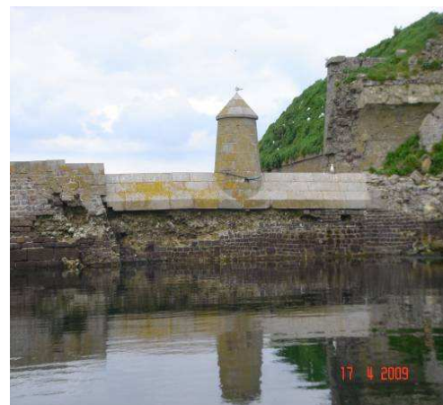
La dame et le batardeau avant travaux
