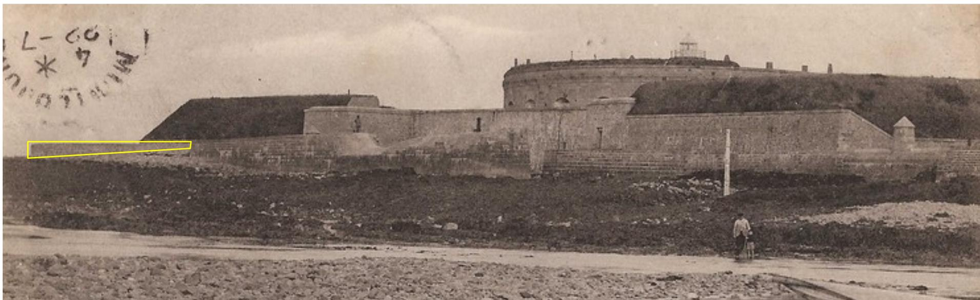
Large de deux mètres, haute de deux à quatre, et longue de plus de cent cinquante mètres, la digue nord-est part du batardeau pour rejoindre la roche sur la façade est de l'île. Malgré sa solidité, et faute d'entretien, les pierres commençaient sérieusement à se déliter en 2009 lors du premier chantier de l'association. Depuis, elle est sauvée et chaque année nous améliorons son état en retravaillant des zones de joints qui sont refaits à la chaux.
