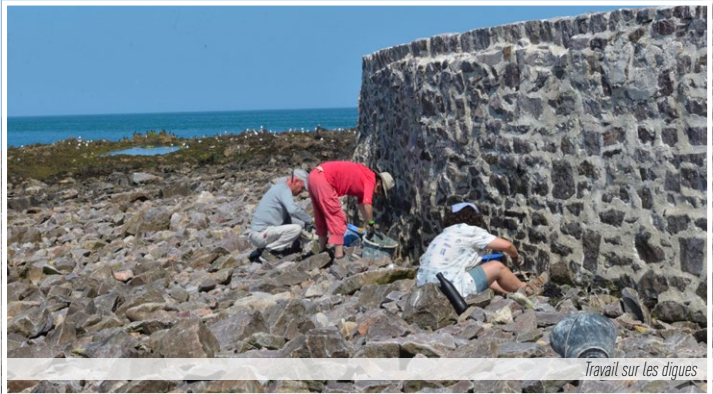
Reprise des joints du quai du poste de garde nord
